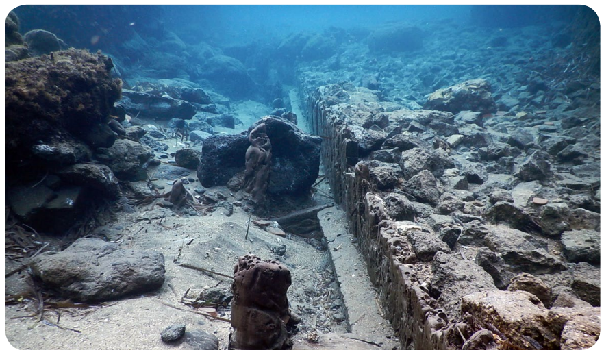
Fig. 4 - Cartaromana - Resti della banchina portuale e della cassaforma lignea utilizzata per la sua costruzione
