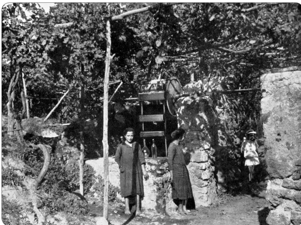
Il pozzo del Pontano
