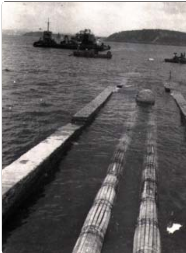
Ischia - Posa della prima condotta sottomarina (anno 1958)
